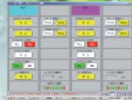
▲オーバービュー画面 バルブ・ポンプ等のON/OFF遠方操作・計測点の一括監視を行うための画面です。1画面を32マスに区切り、1マスには計測値、計器グループの異常表示8点、ON/OFF状態表示3点、ON/OFF遠方操作3点いずれかに使用できます。1マスをグループ等の名称表示に使うことも可能です。
