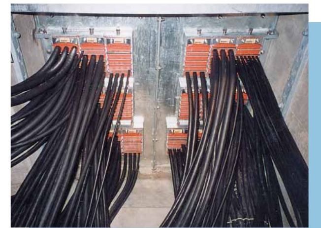
▲ピット 壁貫通
