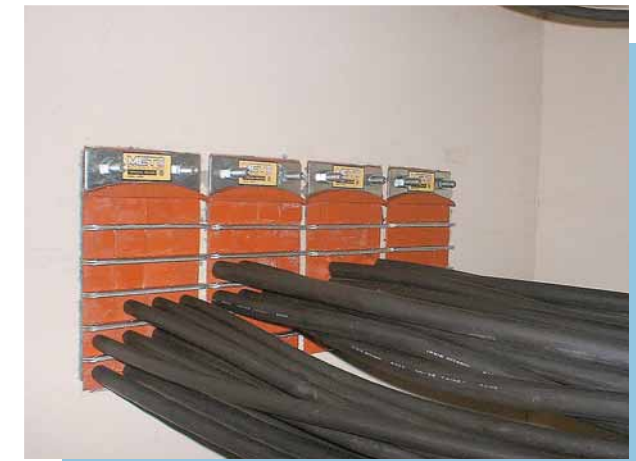
▲地下通路 壁貫通
