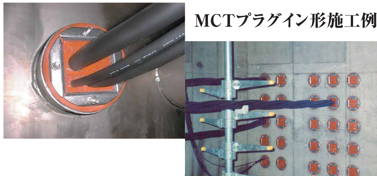
①貫通フレームを開口部に挿入します。 ②電線を貫通フレームに通します。 ③インサートブロックを組合わせます。 ④ナットを締めて作業は完了します。
