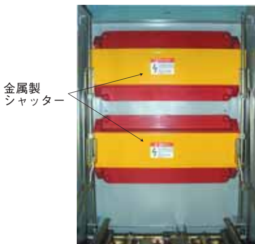
真空遮断器クレードル用金属製シャッター
